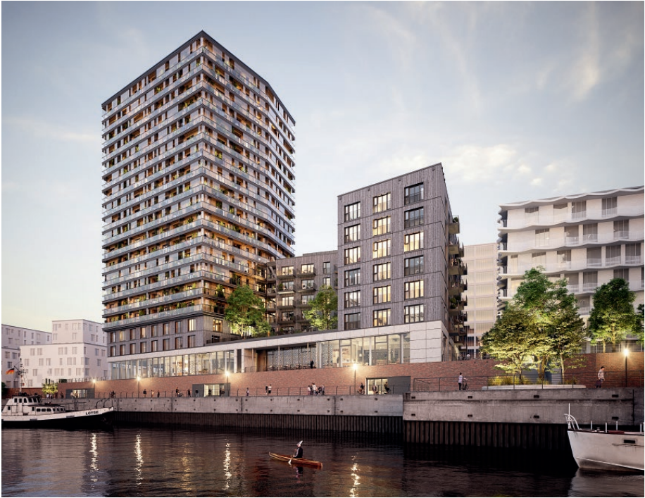
Wird mit 65 Meter Höhe und 18 Obergeschossen das höchste Holzhochhaus Deutschlands: Das „Roots“ in der Hamburger HafenCity.
