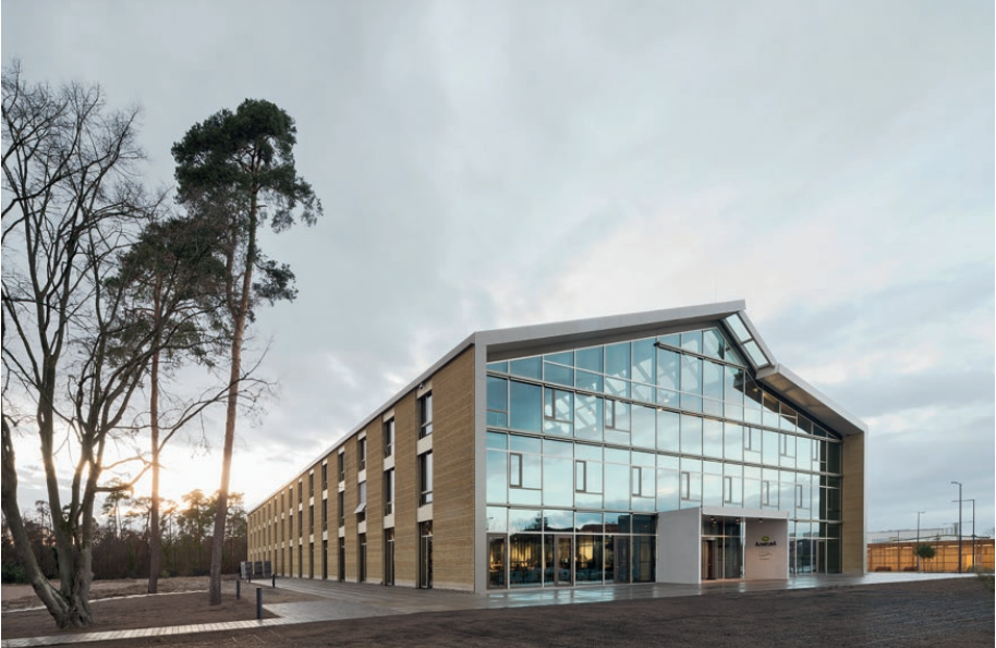
Vielfach ausgezeichneter Alnatura Campus in Darmstadt mit Außenfassaden aus Stampflehm.
